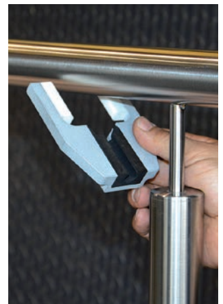
Abführen der Vorrichtung und Fertigstellen der Schweißarbeiten
